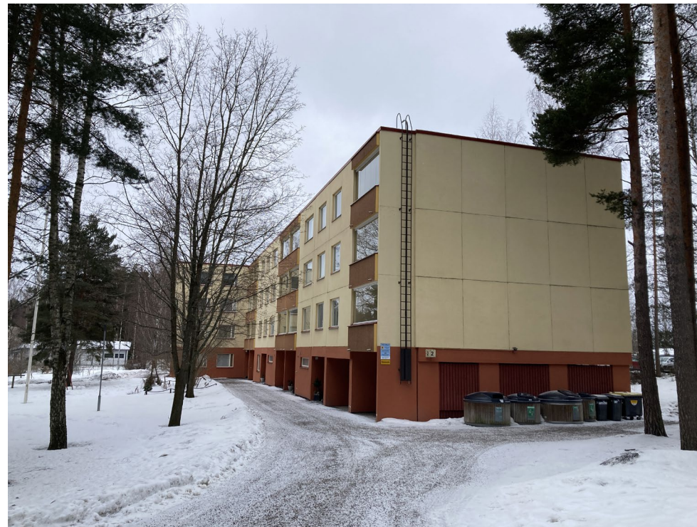
5: Matala korotuspotentiaalia omaava rakennus tontilla 9
