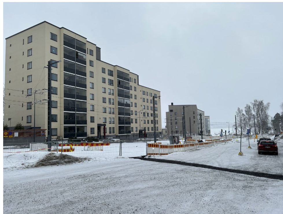
2: Rakennus terassoituu Lielahdenkadun suuntaan
