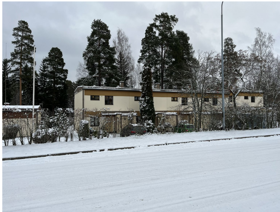
5: Rivitaloalue Suomensaarenkadun puolelta
