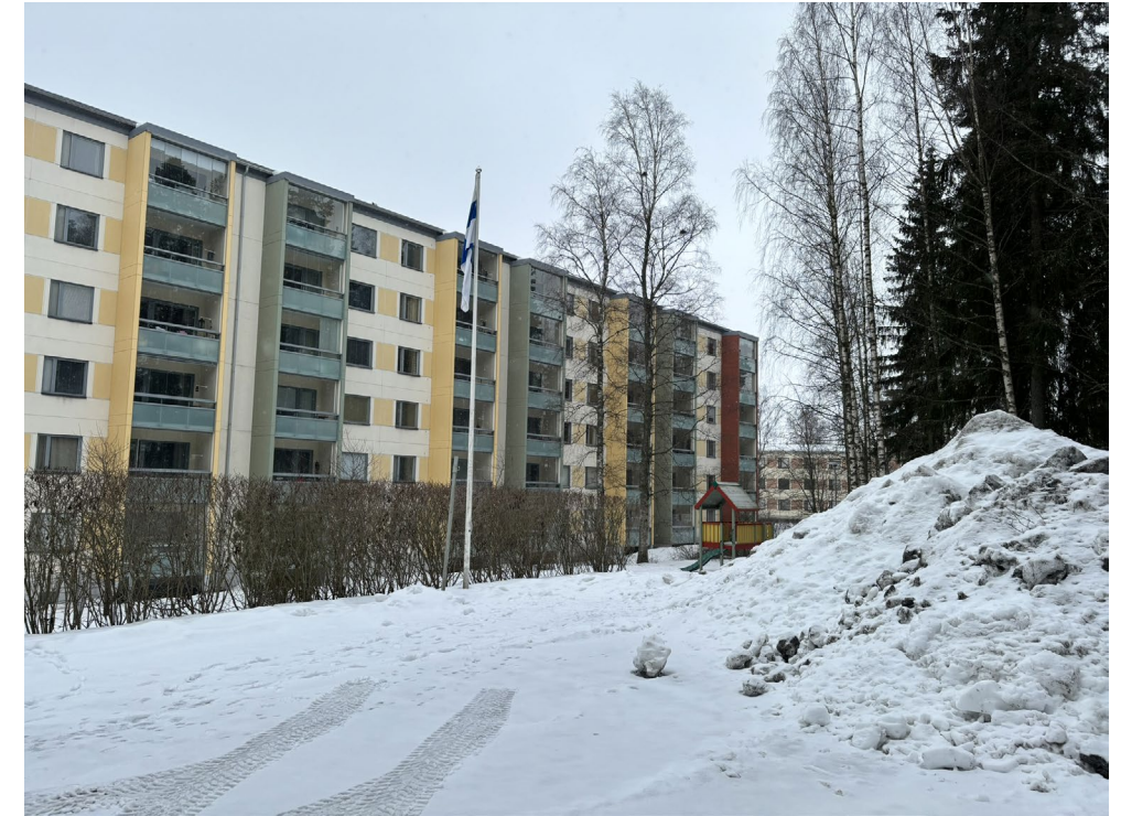
3: Julkisivu ja parvekkeet saneerattu tontilla 4
